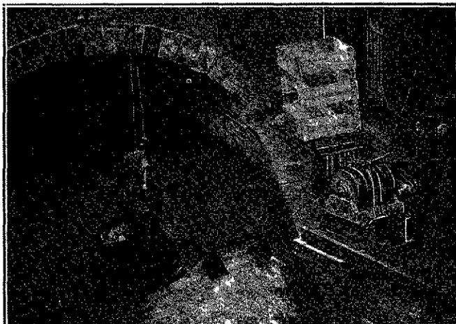
Curage d'un canal en tunnel par SCRAPPER PIC ABO alimentant une benne
